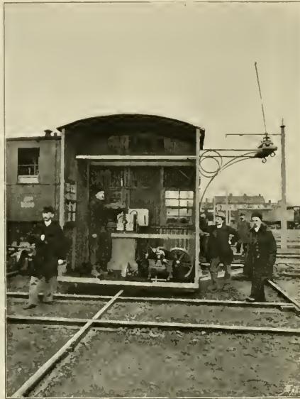
Abb. 352. Motorhäuschen der elektrisch betriebenen Schiebebühne.
